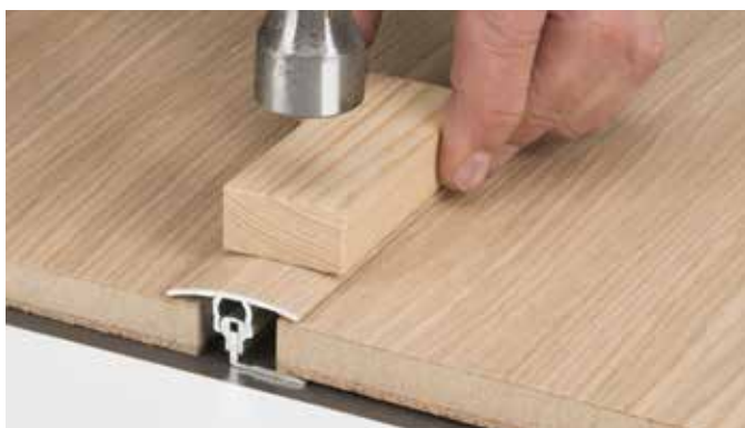
Instalace přechodového profilu hliníkového
