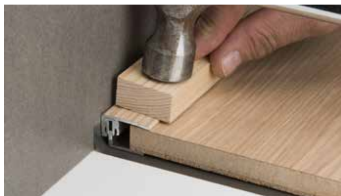
Instalace ukončovacího profilu hliníkového
